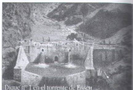
Dique nº 1 en el torrente de Enseu
